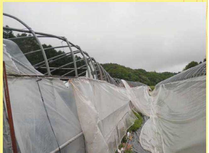
雪で倒壊したハウス
